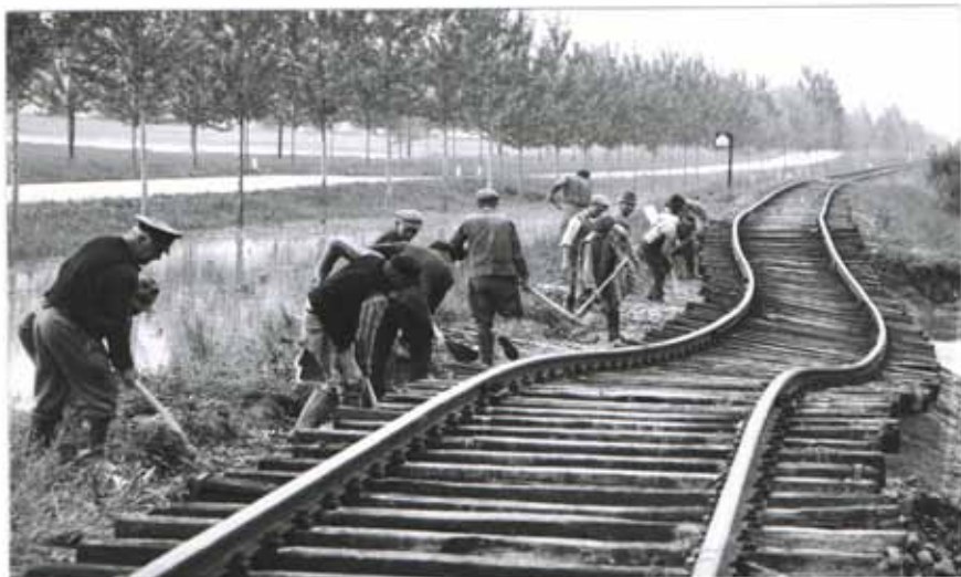
Lucrări de reparații la calea ferată Sighișoara-Odorhei
