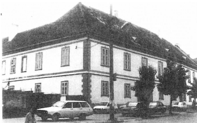
Fig. 90. Prefectura veche, aspect general.
