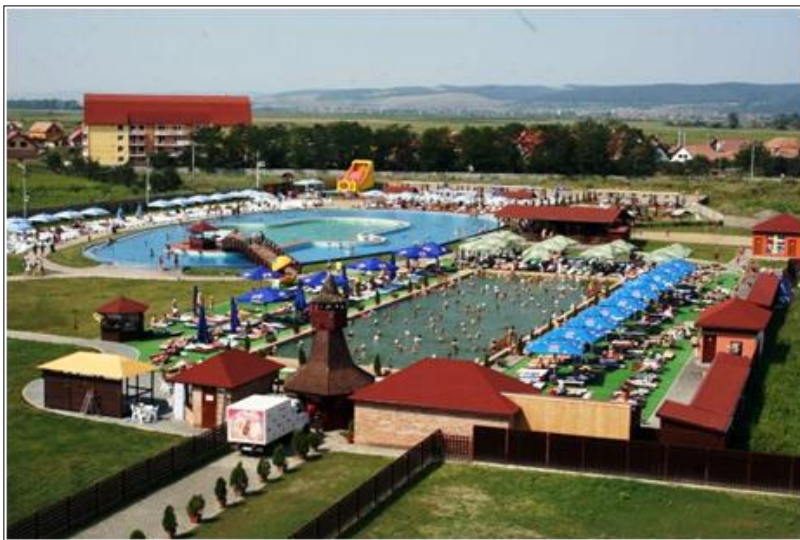
2016. Vedere generală a bazinelor cu apă sărată și apă dulce
