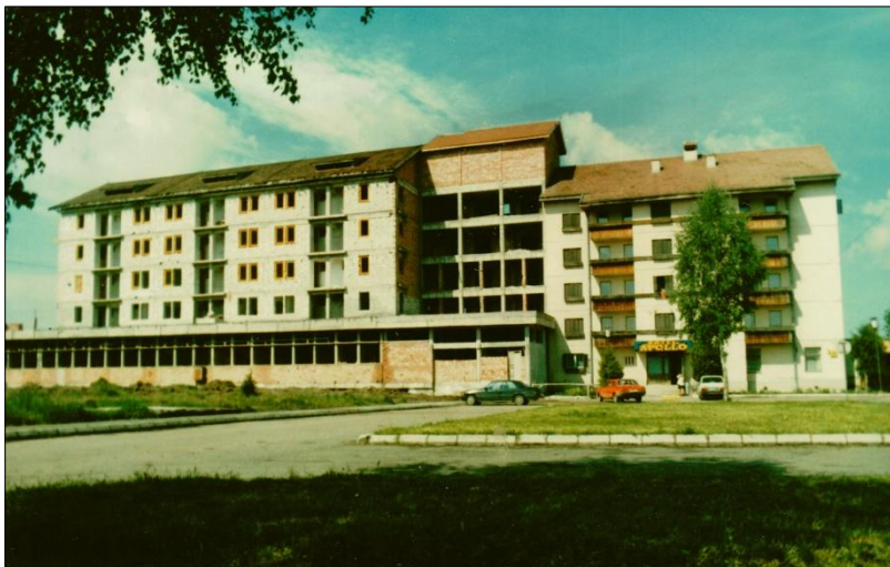
1998. Noua Bază de tratament, în construcție
