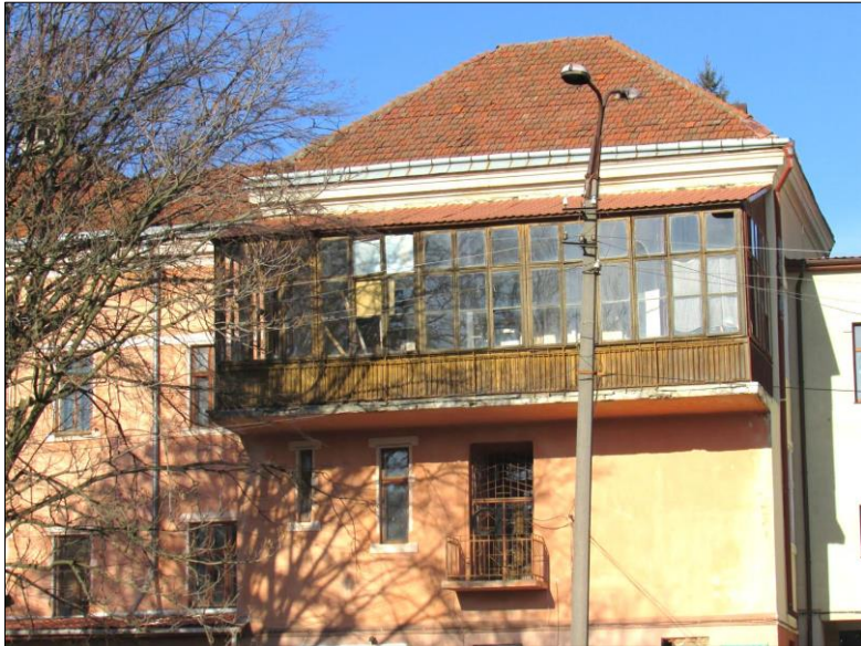
Pavilionul sudic al Spitalului de Copii în care a trăit I. Bodea până la pensionare (1929) - vedere din stradă
