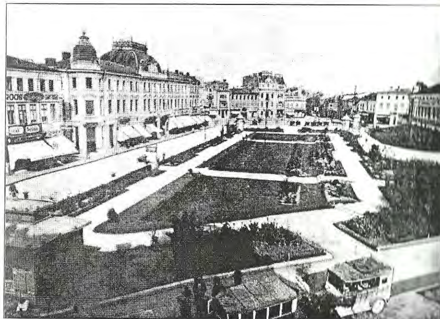
Piața centrală a Ploieștiului amenajată în 1926
