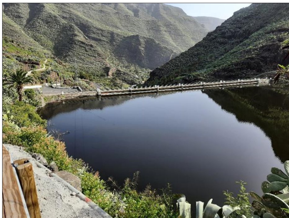
Apa este adunată și drămuțită cu mare grijă
