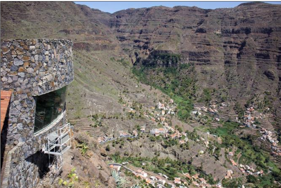
Construit cu fonduri europene, Restaurantul a fost abandonat, părăsit
