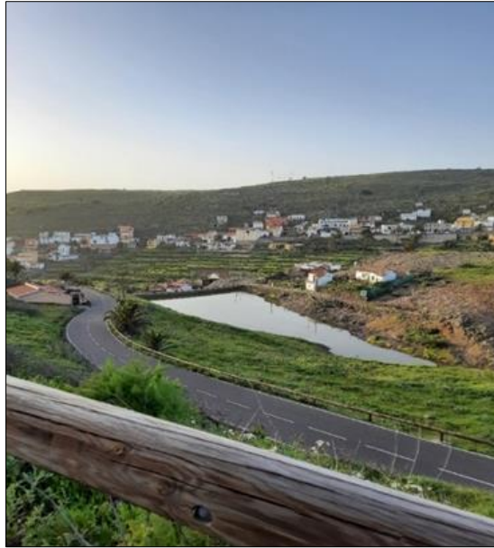
Apa se adună și se drămuiește în sisteme de acumulare
