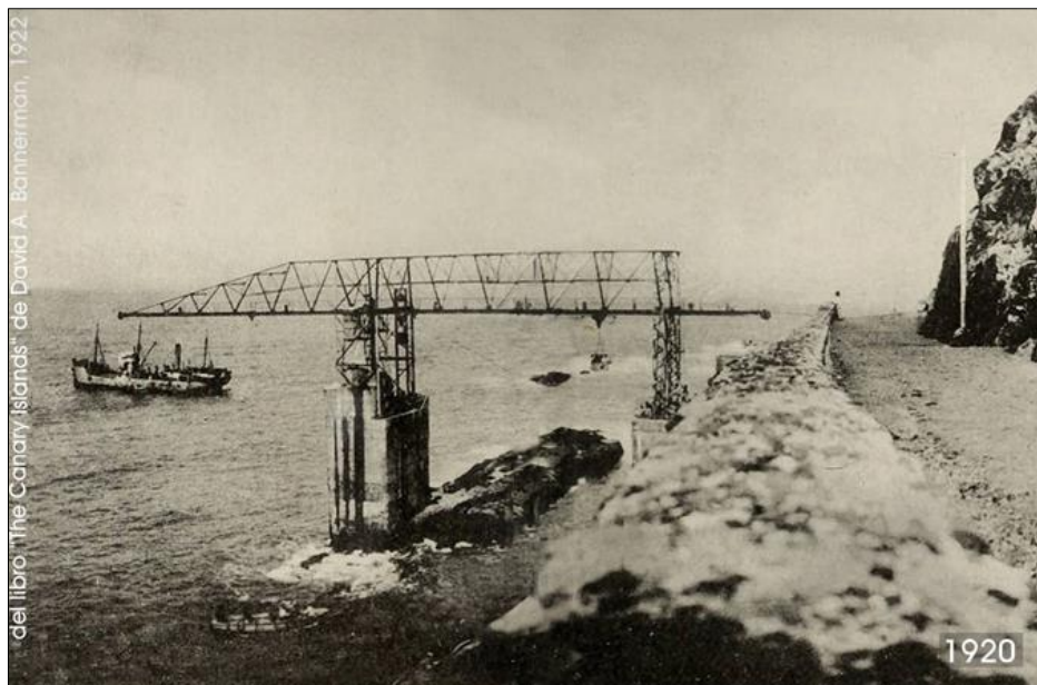
Imagine de epocă. Instalația cu care se încărcau vapoarele cu marfă
