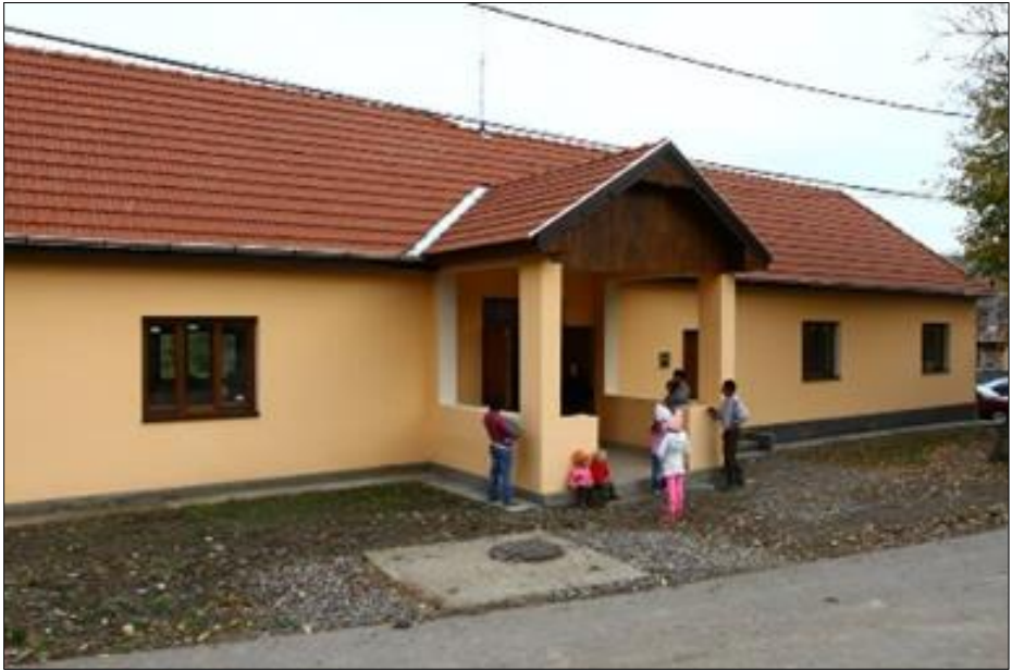
Căminul Cultural, recent renovat
