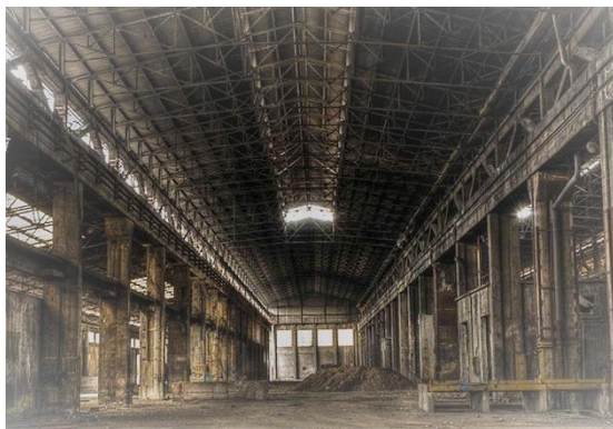
Construcția unei hale noi- Turnătorie
