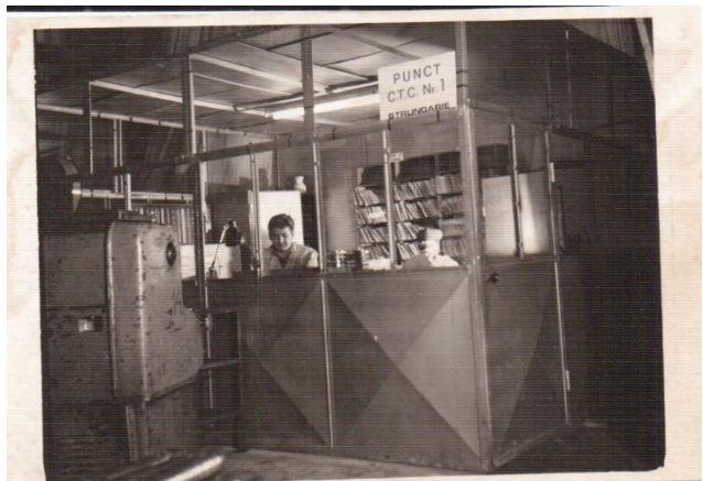
Spații amenajate în secții pentru protejarea aparatelor de măsură și control
