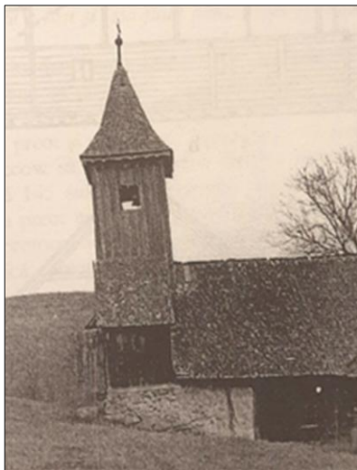
Acoperișul Bisericii de lemn de la Ungureni, cu șindrila foarte deteriorată
