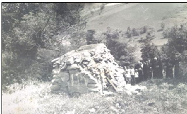
Singura rămășiță rămasă după devastatorul incendiu, fundația, postamentul Clopotniței
