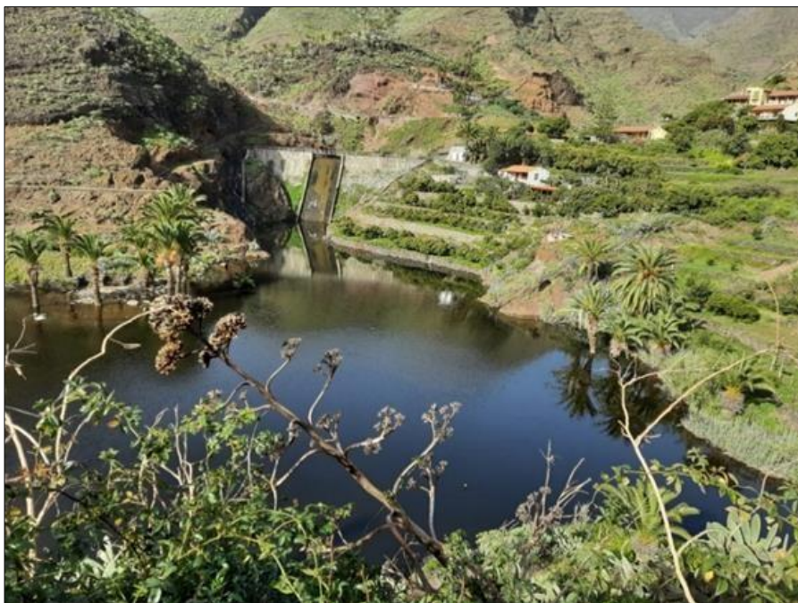
Un baraj ce ceează un peisaj de basm
