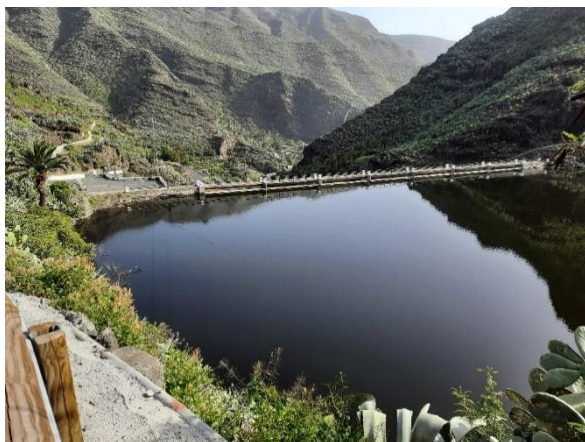
Un baraj de acumulare amenajat
